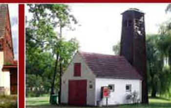
Werder: Sanierter Schlauchturn
