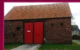
Neuhof - Schwerpunkt Feuerwehrgerätehaus
